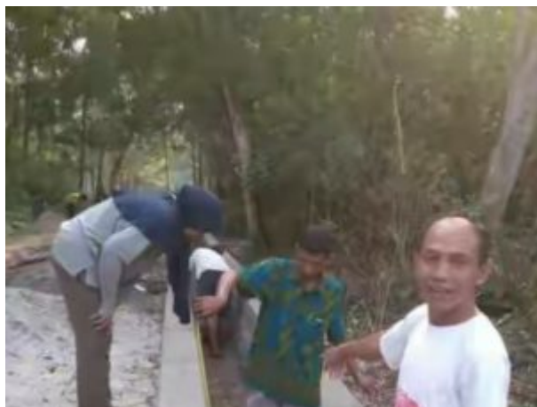
Pembangunan Drainase Desa Pasir Sakti
